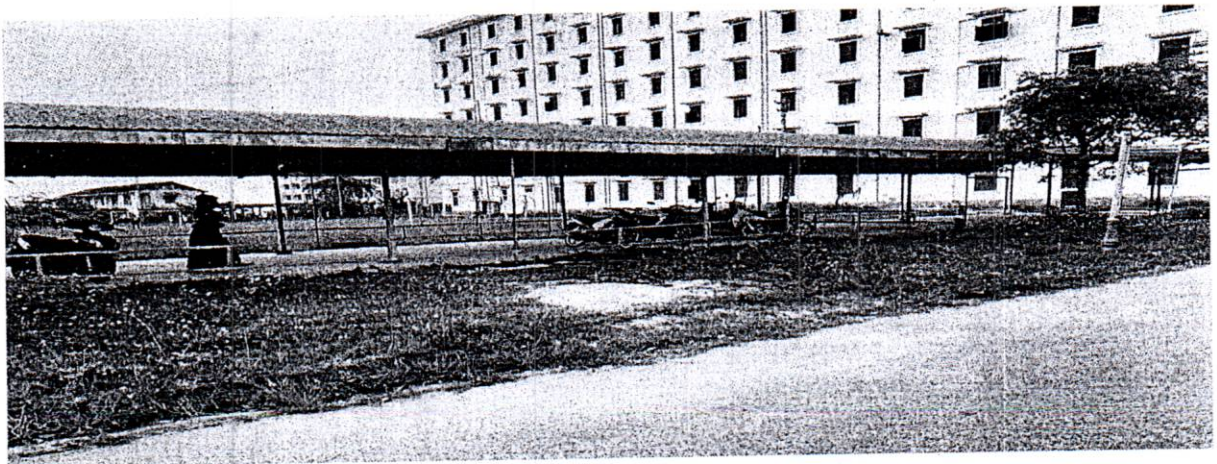
Bãi xe số 3: Có thể đưa vào khai thác, sử dụng được. Cần thay các bóng đèn điện hư hỏng
